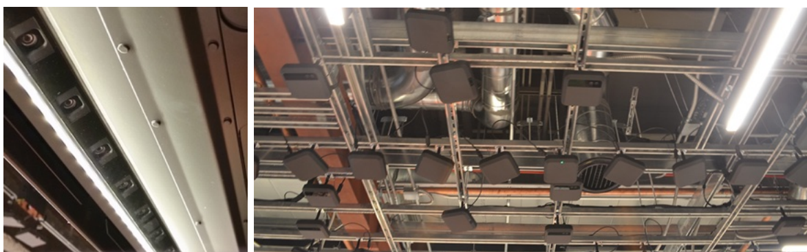
Figuur 9: Rijen met camera's in schappen en aan de plafonds van Amazon Go winkels 48
